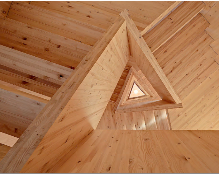
Holz in Holz – der dreieckige Treppenaufgang, präzise eingefügt in die gleichförmige Außenwand des Kirchturms
