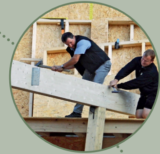
Holzbau Zimmerei Schreinerei
