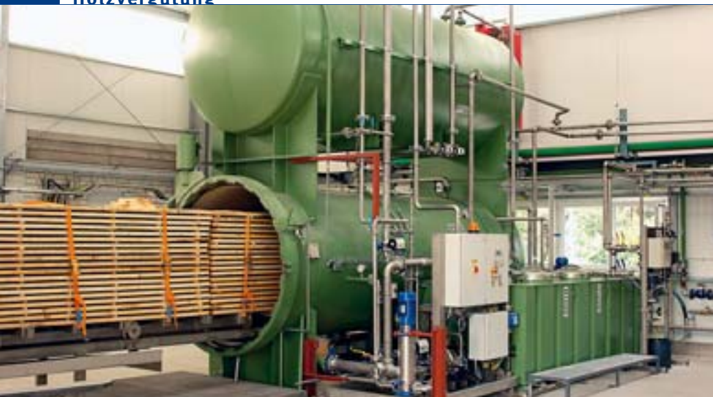
In der BASF-Pilotanlage auf dem Werksgelände in Ludwigshafen, gebaut 2005, hat das neuartige Belmadur-Verfahren seine Praxistauglichkeit in den vergangenen Jahren hinlänglich unter Beweis gestellt
